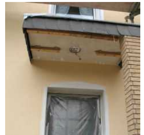
Nicht abgebaute Wärmebrücke –Ausragende Balkonplatte oder Vordach als „Kühlrippe“ Wärmeverlust, Kondensat-Schimmelpilzgefahr
