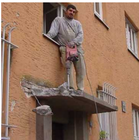
Abbau einer Wärmebrücke, punktuell befestigtes Vordach
