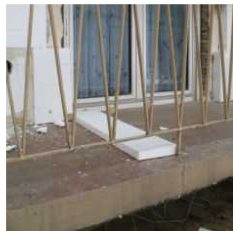
Nicht abgebaute Wärmebrücke –Ausragende Balkonplatte oder Vordach als „Kühlrippe“ Wärmeverlust, Kondensat-Schimmelpilzgefahr
