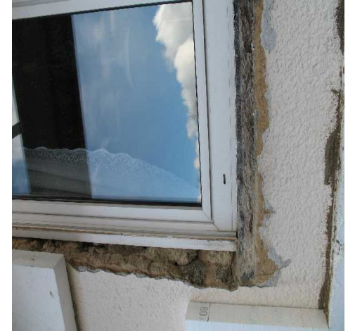
Eingebaute Wärmebrücke unter Fensterbank Wärmeverlust, Kondensat-Schimmelpilzgefahr
