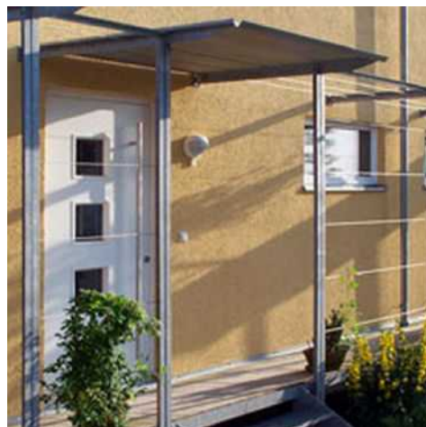
Abbau einer Wärmebrücke, punktuell befestigtes Vordach
