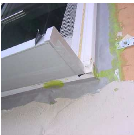
Luft-/Winddichter Anschluss, Luftdichtigkeitsebene auf der Außenfassade
