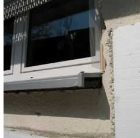
Eingebaute Wärmebrücke unter Fensterbank Wärmeverlust, Kondensat-Schimmelpilzgefahr
