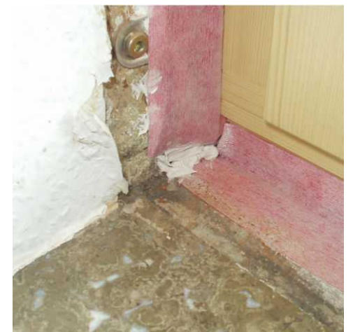
Luftdichtigkeit? Wärmeverlust, Schimmelpilzgefahr
