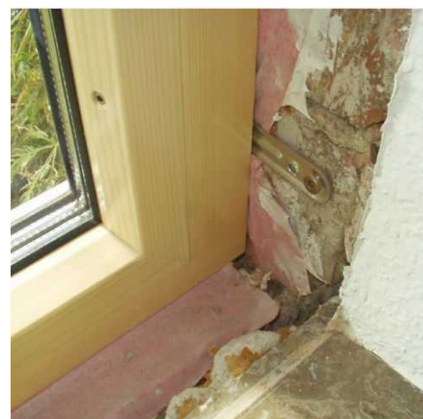
Luftdichtigkeit? Wärmeverlust, Schimmelpilzgefahr
