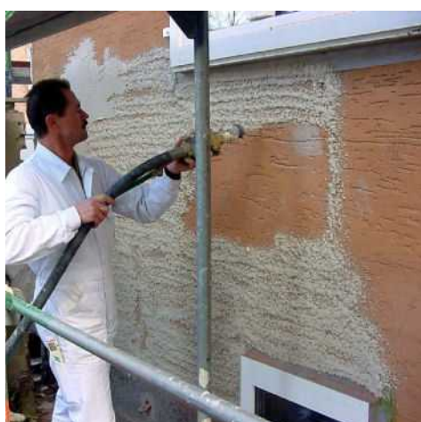
Luft-/Winddichter Anschluss, Luftdichtigkeitsebene auf der Außenfassade
