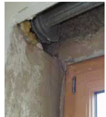
Umgang mit kritischen Stellen, z.B. auskragenden Stahlbetonplatten, Traufe, Rolladenkästen, Fenster..
